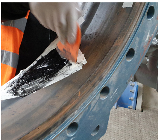
Naprawa uszkodzonej wykładziny gumowej przepustnicy
