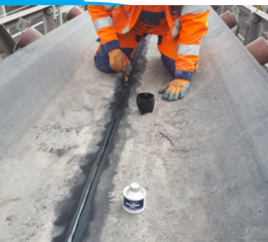
Ekspresowa naprawa rozcięcia wzdłużnego taśmy przenośnika
