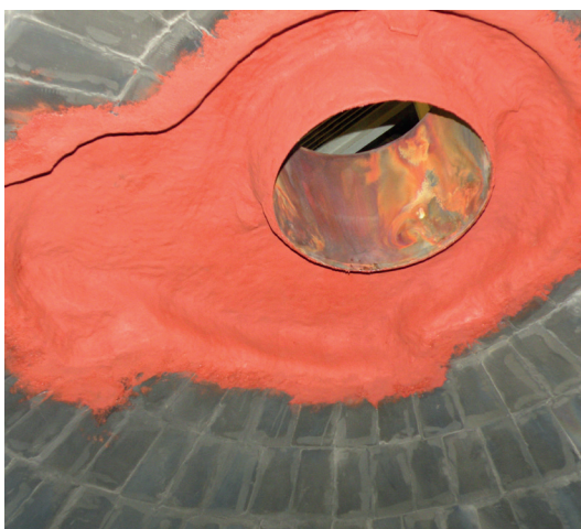
Naprawa wymurówek chemooodpornych w kolumnach procesowych
