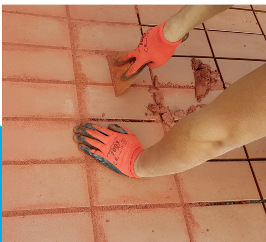
Spoinowanie płytek chemooodpornych tacy stężonego kwasu azotowego
