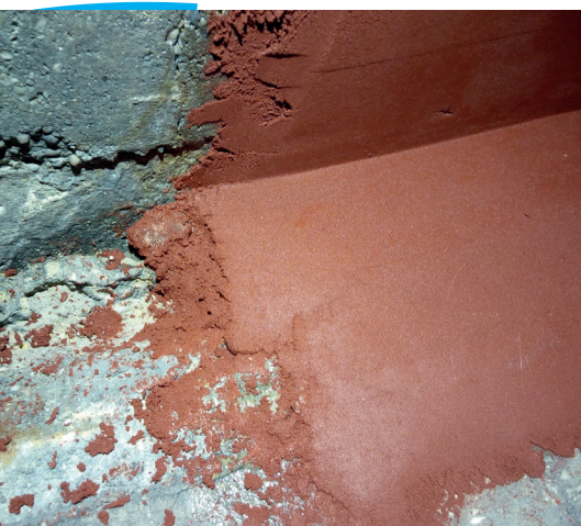
Reprofilacja i zabezpieczenie kanałów ścieków agresywnych
