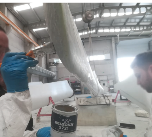
Belzona 5721® - aplikacja kompozytu jednowarstwowo
