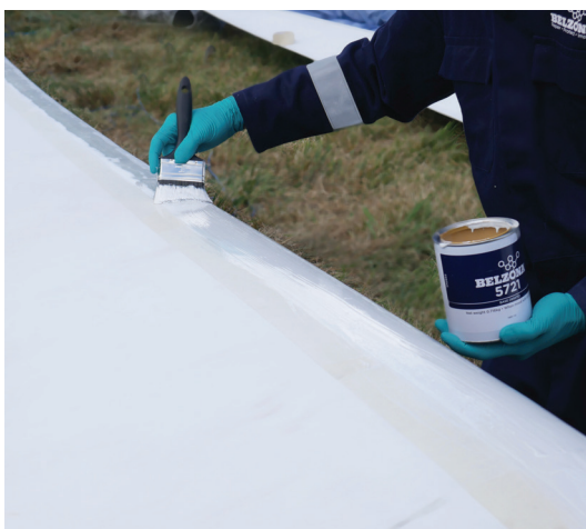
Belzona 5721® - aplikacja w miejscu eksploatacji
