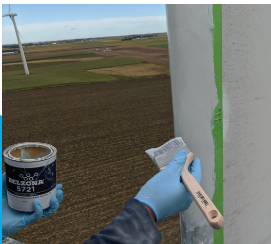
Aplikacja Belzona®5721 na wysokości – jednowarstwowo
