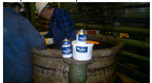
aplikacja powłoki wewnątrz kopuły górnej
