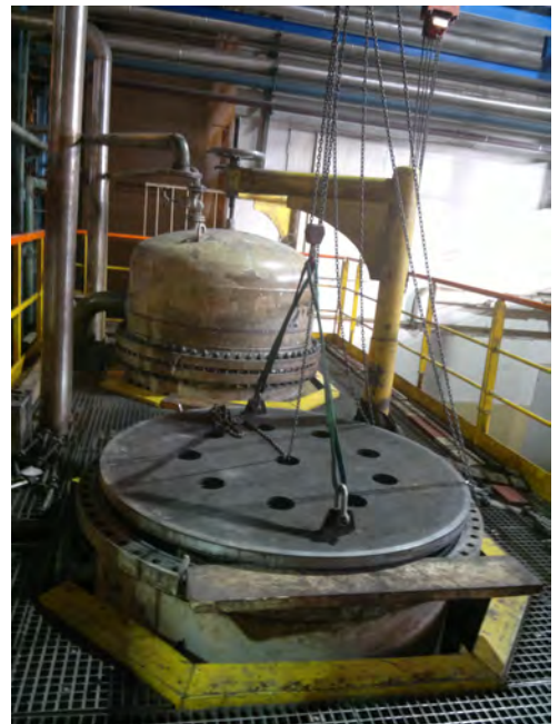
widok filtra po demontażu górnej części
