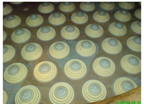
powierzchnia po naprawie oraz po zamontowaniu filtrów
