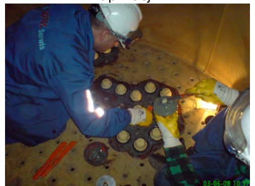
odbudowa wykładziny metodą na odwzorowanie
