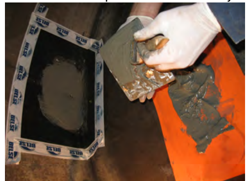
Uszkodzenie powłoki ebonitowej
