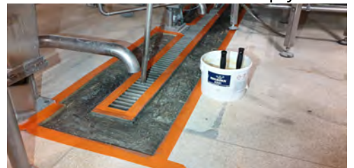
aktywacja podłoża materiałem Belzona 4981
