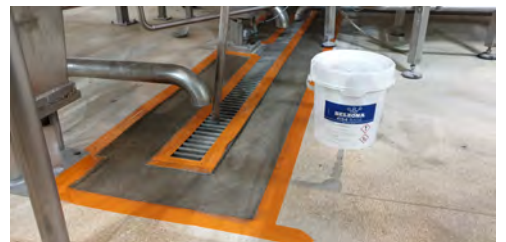
odbudowa większych ubytków mieszaniną piasku kwarcowego z żywicą Belzona 4154
