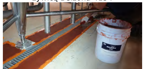
aplikacja kompozytu Belzona 4181
