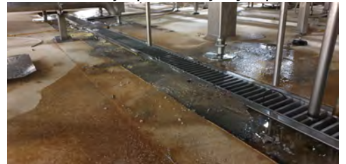
demontaż blach wokół odpływu
