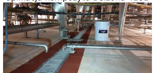
aplikacja kompozytu Belzona 4181
