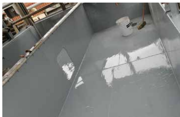
Fot.4b. Wanna ociekowa (basen) wieży chłodniczej zabezpieczonej powłoką Belzona5811
