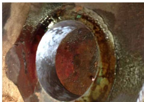
Otwór przygotowany do aplikacji kompozytu Belzona1111
