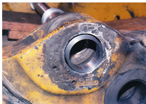
Centrowanie przygotowawcze tulei przed nałożeniem kompozytu Belzona111
