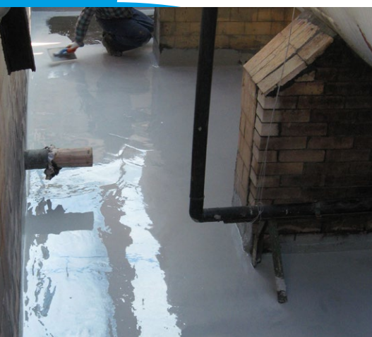
Wykonanie wykładziny chemoodpornej oraz mechanicznie obciążalnej tacy zbiornika
