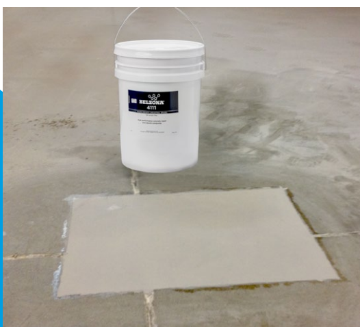
Lokalna naprawa posadzki kompozytem Belzona® 4111
