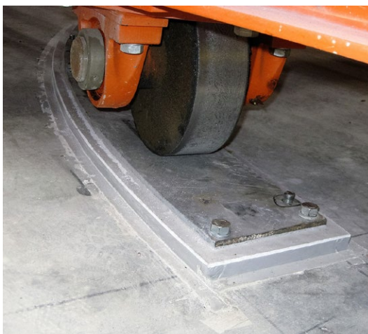
Zwiększenie obciążalności styku metal-beton kompozytem Belzona® 4111
