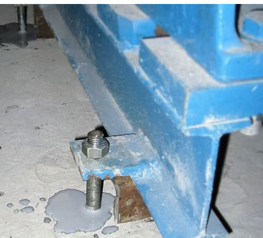
Kotwienie maszyn kompozytem Belzona® 4111
