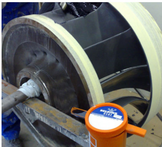
Belzona 2141 nakładany na wirnik turbiny Francisa
