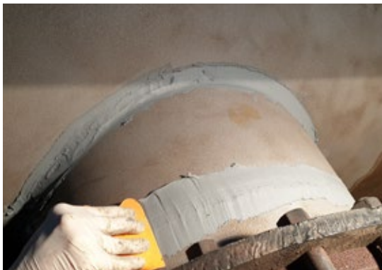
Fot.2. Profilowanie spoin kompozyte Belzona® 1111
