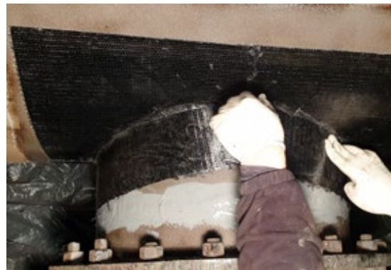
Fot.4. Nałożenie bandaża Superwrap II na króciec i kolektor
