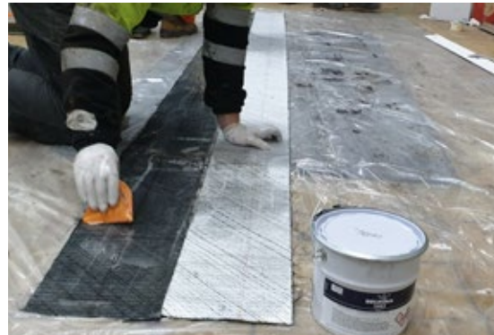
Fot.3. Przygotowanie bandaża Belzona® SuperwrapII
